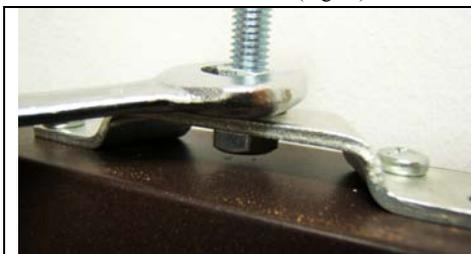
Fig.16 Fissaggio binario a parete mediante tasselli
