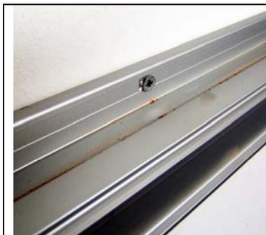
Fig. 12 Fissaggio binario a parete mediante tasselli
